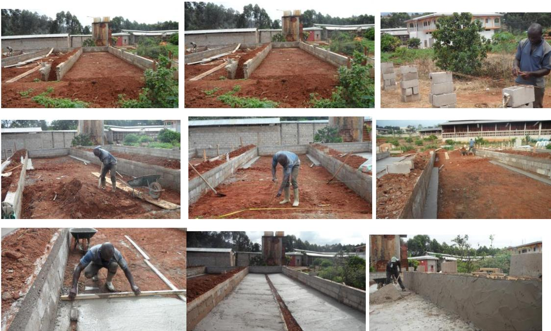
Le dispositif expérimental mis en place est un système de lit de séchage non plantés. Il consistera à appliquer les E.U (251-50l) dans le système pendant une semaine. Son percolât sera conduit dans un lac artificiel planté de roseaux (*Echinochloa pyramidalis*) pour poursuivre le traitement (Fig.6).
