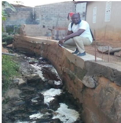
Fig. 21. Ecoulement des eaux usées de l'abattoir dans couloir des habitations situé à environ 2m de l'abattoir.
