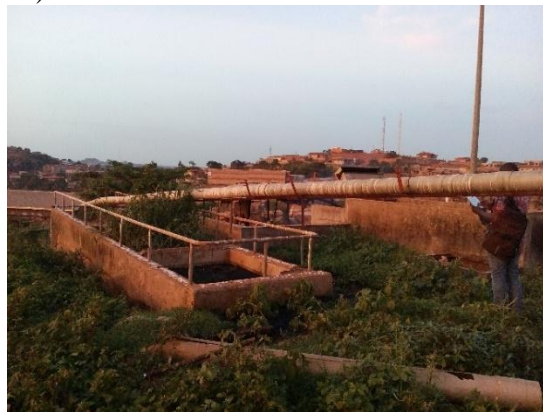
Fig.16. Système de collecte et transport des déchets liquides.
