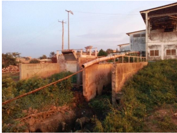
Fig.11. Equipement d'assainissement defectueux.
