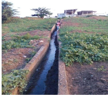
Fig.18.L'évacuation des eaux usées de l'abattoir vers le cours d'eau Ako'o.
