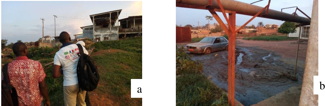
Fig. 20. Etat de l'environnement de l'abattoir (a- perte de l'esthétique de l'abattoir ; b- drainage des eaux usées aux alentours de l'abattoir).
