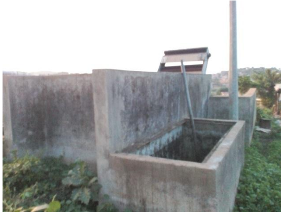
Fig.15. Lieux de stockages des déchets liquides.
