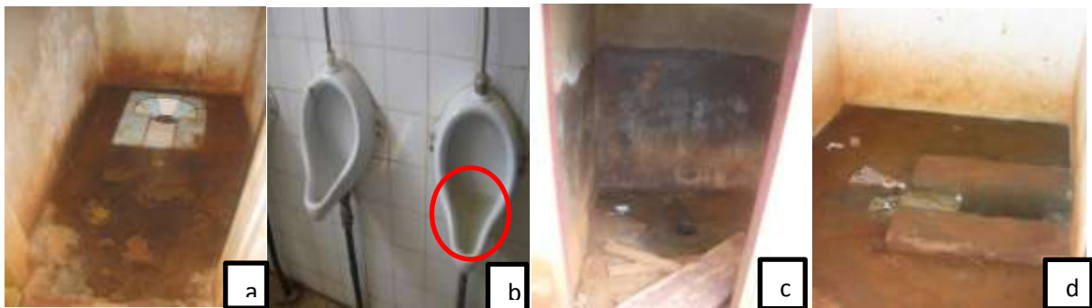
Fig. 28. Entretien des latrines dans les lycées (a, b, c, d : entretien des latrines)
